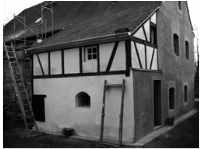
DIE FERTIG GESTELLTE KÖRNERSTUBE UND DER VERPUTZTE WESTGIEBEL
